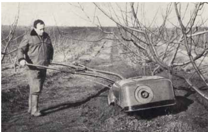
Aratro a motore Galardi-Patuzzo, 1915 circa. Il motore a sbalzo anteriore da 3 a 10 CV, a benzina o petrolio, trasmette il moto mediante una serie di cinghie all'unica ruota motrice. Il peso, compreso l'aratro a due solchi, è di 380 kg
