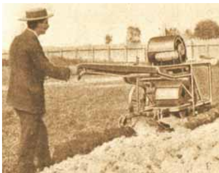
Aratro a motore Galardi-Patuzzo, 1915 circa. Il motore a sbalzo anteriore da 3 a 10 CV, a benzina o petrolio, trasmette il moto mediante una serie di cinghie all'unica ruota motrice. Il peso, compreso l'aratro a due solchi, è di 380 kg
