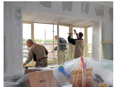
↑ Het monteren gebeurt in droogbouw: sneller én schoner!
