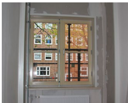
↑ De voorzetwand kan op allerlei manieren worden afgewerkt: met Faay-wandbespuiting, verf, sierpleister, tegels of stucwerk.
