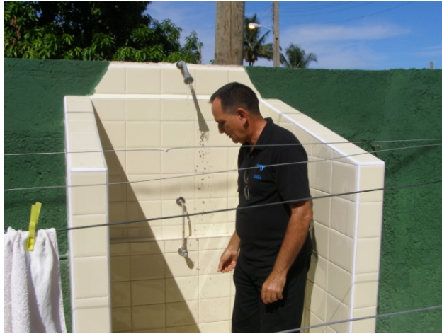
De buitendouche - gebruikelijk in Cuba - bij het weeshuis; alle materialen komen uit Nederland.
